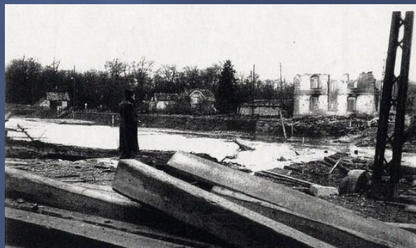
Le pont de Krafft après sa destruction
