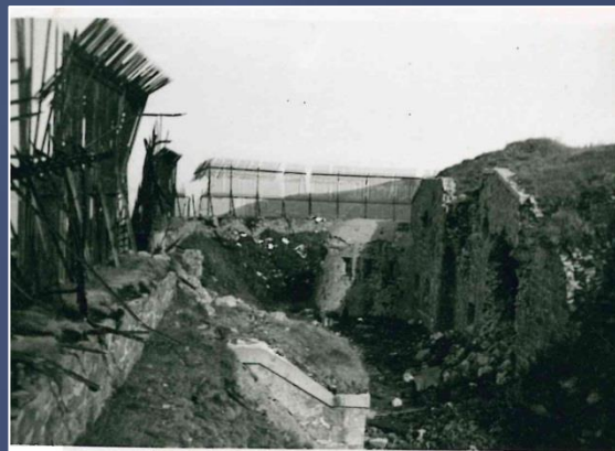
Les fossés du fort de Mille Fourches - Fonds François Engelbach -
