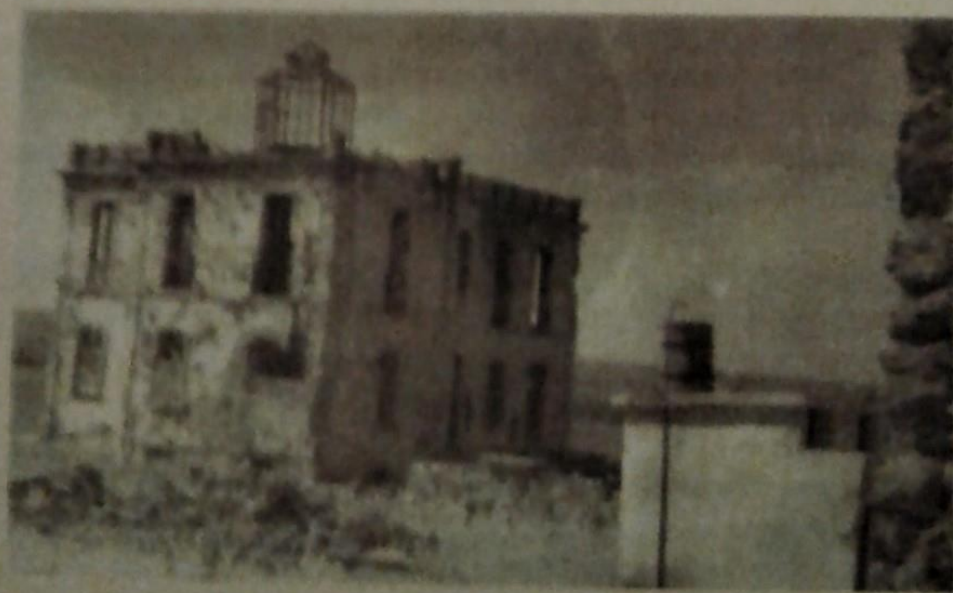
Tobrouk 1955 Reste d'un immeuble où Rommel aurait installé son quartier général.
